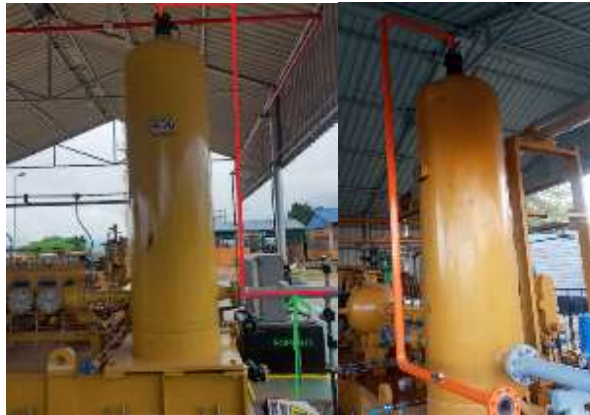
Figura 4. Arreglo para alivio de GLP en dâmpfer de succión Entre Ríos
