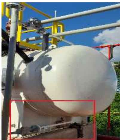
Figura 2. Conexión de 1” para adecuación drenaje de tanque de alivio de GLP V-01
