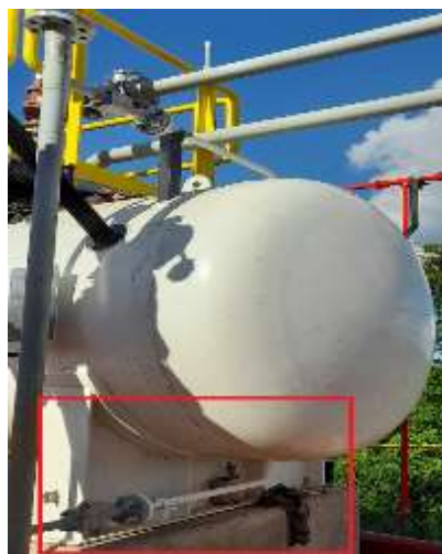
Figura 2. Conexión de 1” para adecuación drenaje de tanque de alivio de GLP V-01
