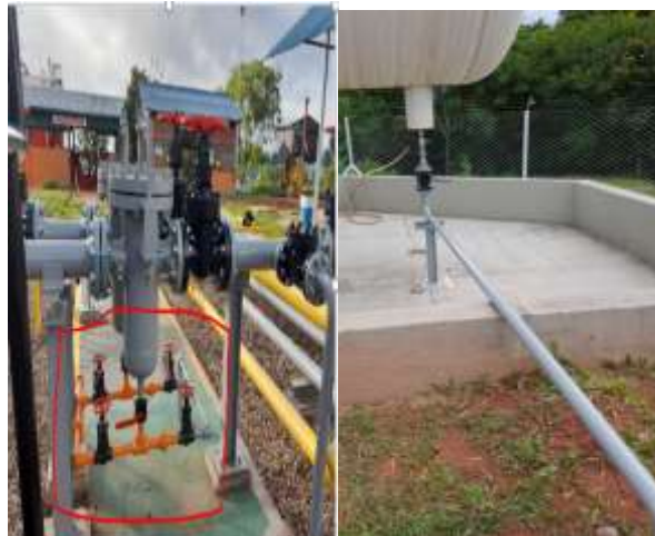
Figura 5. Tuberías de 1" drenaje de filtros de succión a pintar.
