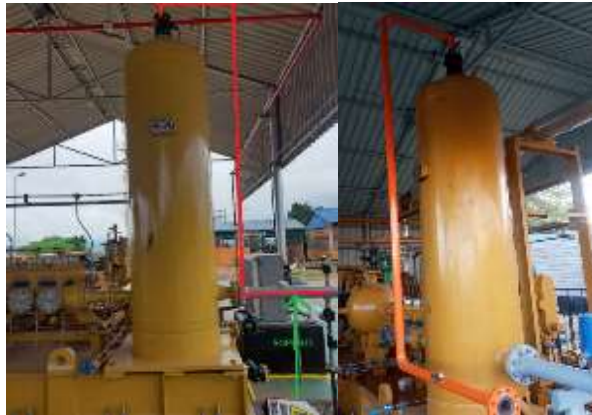
Figura 4. Arreglo para alivio de GLP en dâmpper de succión Entre Ríos
