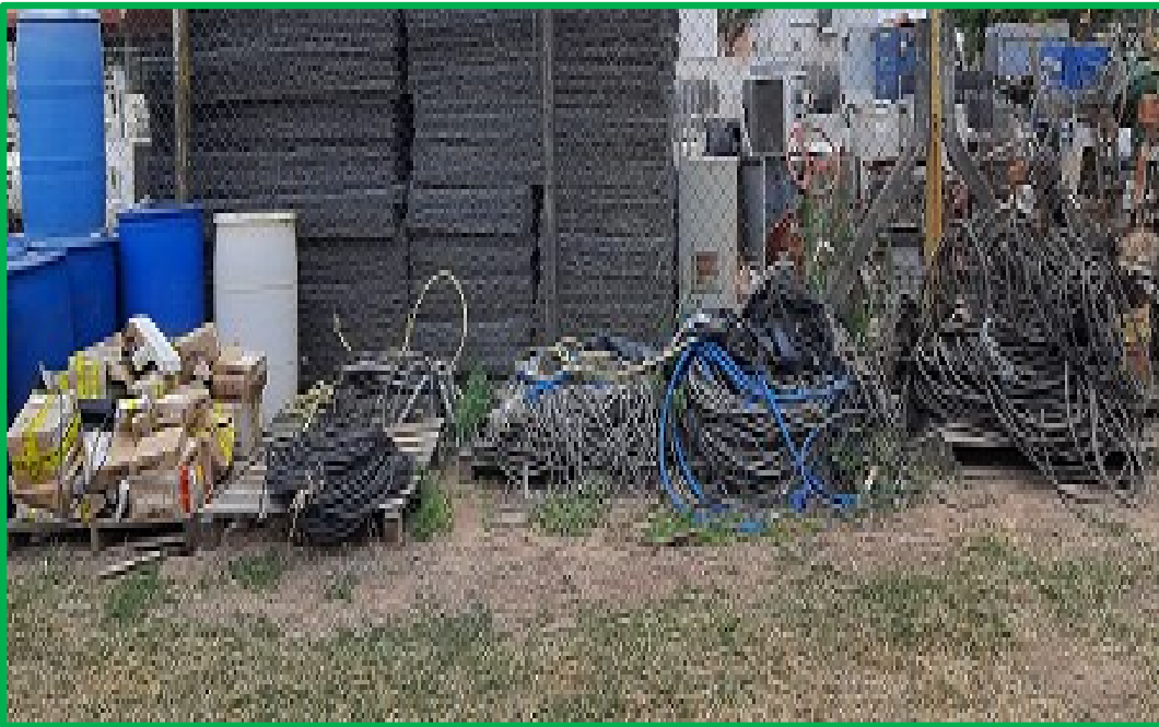
LOTE 5 .- Materiales electricos en mal estado (Cables).
