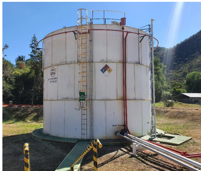
Fotografía N°1. Vista general TK-04
